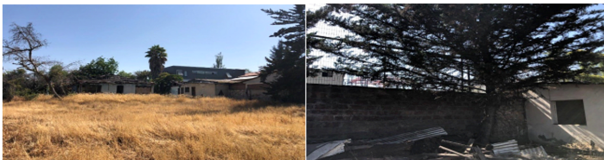
Foto N° 1 Y N° 2. Terreno sin limpiar previo a demolición
