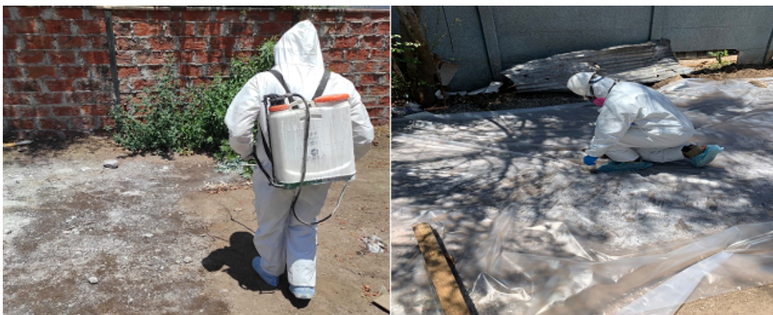
Foto N° 3 y N° 4 Limpieza y Retiro Asbesto Cemento Fuente: Departamento de Proyectos e Infraestructura. Corporación de Desarrollo de La reina, año 2023
